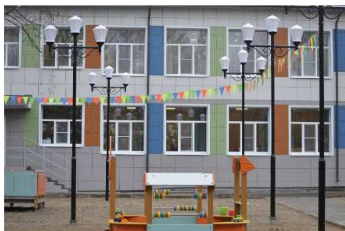
Корпус дошкольного учреждения на 90 мест (МБДОУ «Детский сад общеразвивающего вида № 157"»), ул. Шестернина д.9/4,
